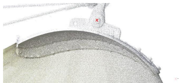
Aufhängung, Hochpunkt Dachkonstruktion
